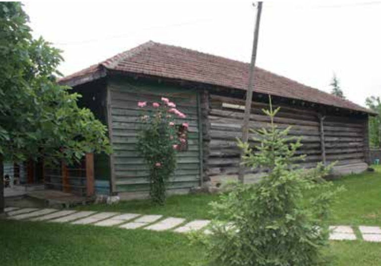
Kaynaşlı Sarıçökek Köyü Orhangazi Camii
